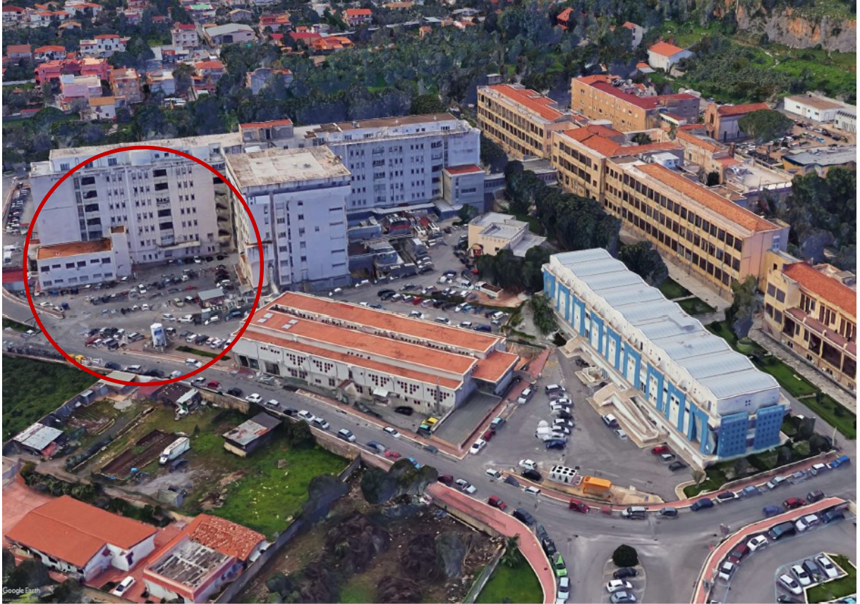
Figura 1 – Ripresa fotografica del retro del padiglione A del P. O. "V. Cervello" con l'indicazione dell'area individuata per l'ubicazione del nuovo edificio.
