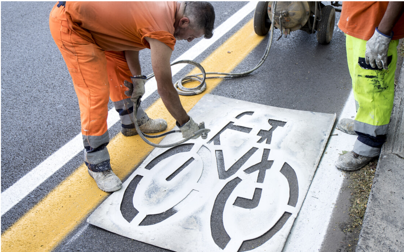
Operai al lavoro per la realizzazione di una pista ciclabile (Foto archivio LaPresse)
