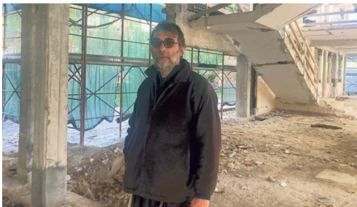
▲ L'impegno Fra Mauro Billetta nello "scheletro" dell'asilo in ristrutturazione a Danisinni
