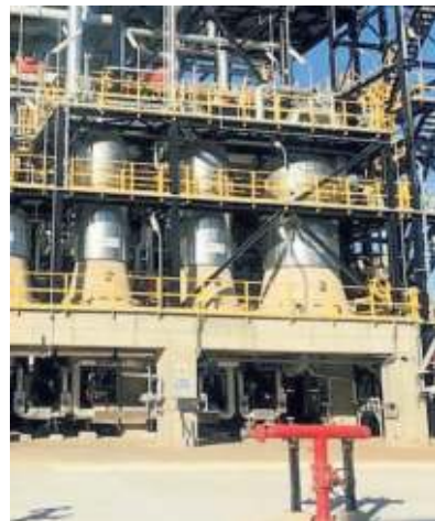
▲ L'impianto La bioraffineria di Gela
