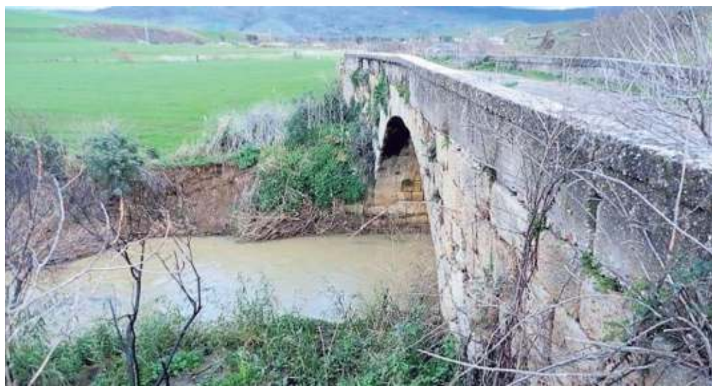
▲ Lo scempio Il ponte tra Mezzojuso e Ciminna demolito dall'Anas con l'ok della Soprintendenza
