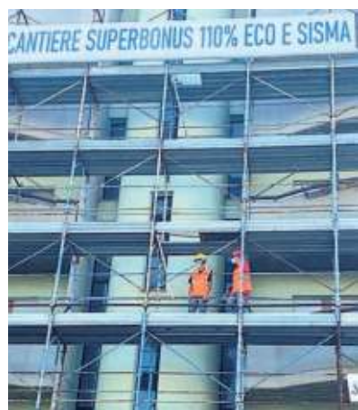
▲ Settore trainante Un cantiere edile del Superbonus
