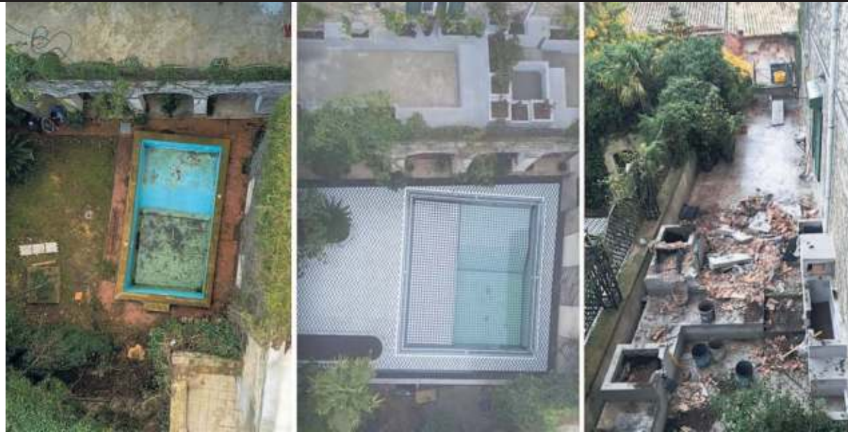
▲ Prima e dopo Il Giardino di Palazzo Bartoli a Mazzarino prima e dopo la demolizione
