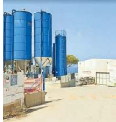
Il cantiere Toto a Ogliastrillo
