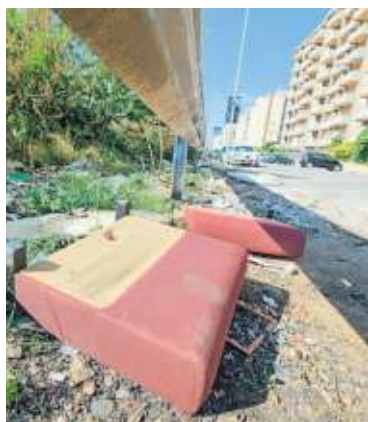
▲ Discariche Nella foto in alto la situazione in via Saverio Latteri e più in basso come si presenta via Lussorio Cau
