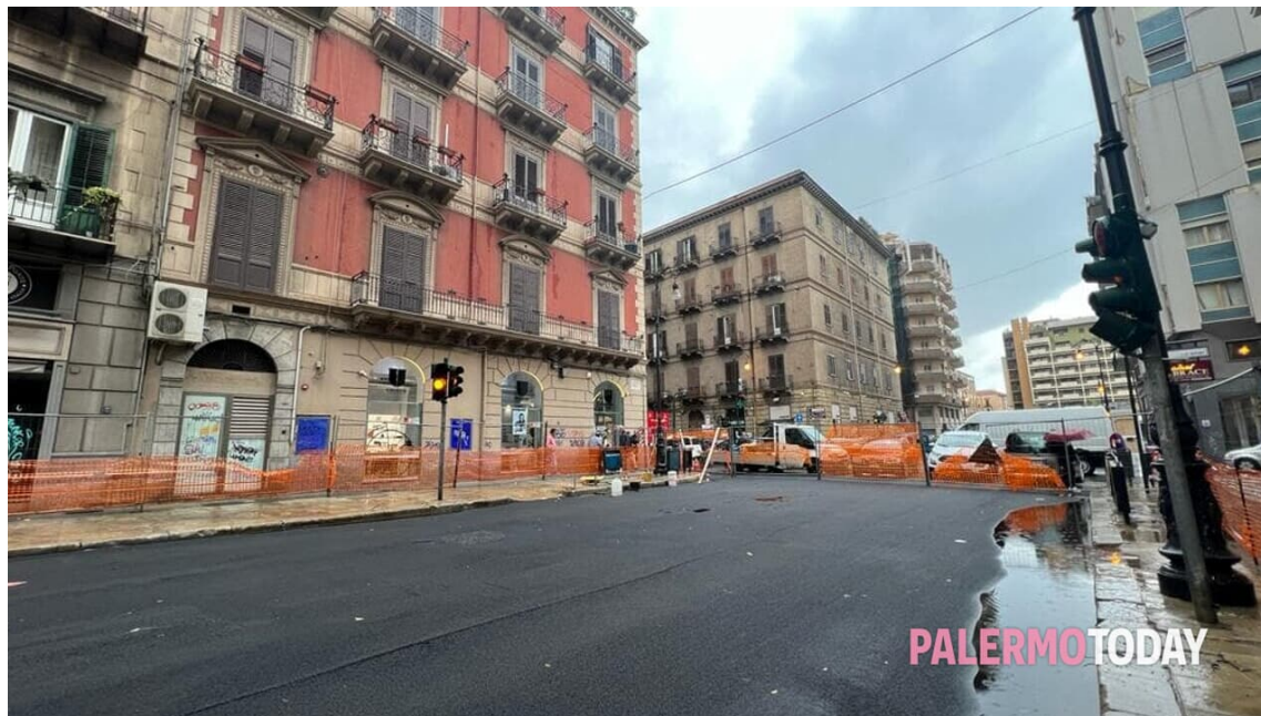
La posa dell'asfalto ultimata in via Roma all'altezza di via Amari
