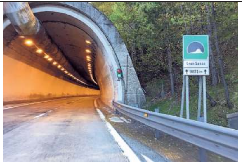
▲ Un tratto dell'Autostrada dei Parchi che collega l'Abruzzo alla Capitale
