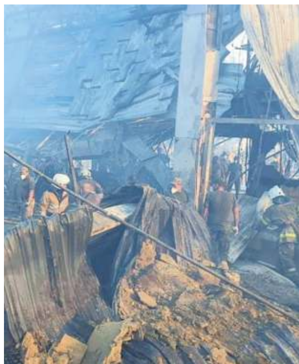
▲ Gli interni del mall distrutti dalle fiamme
