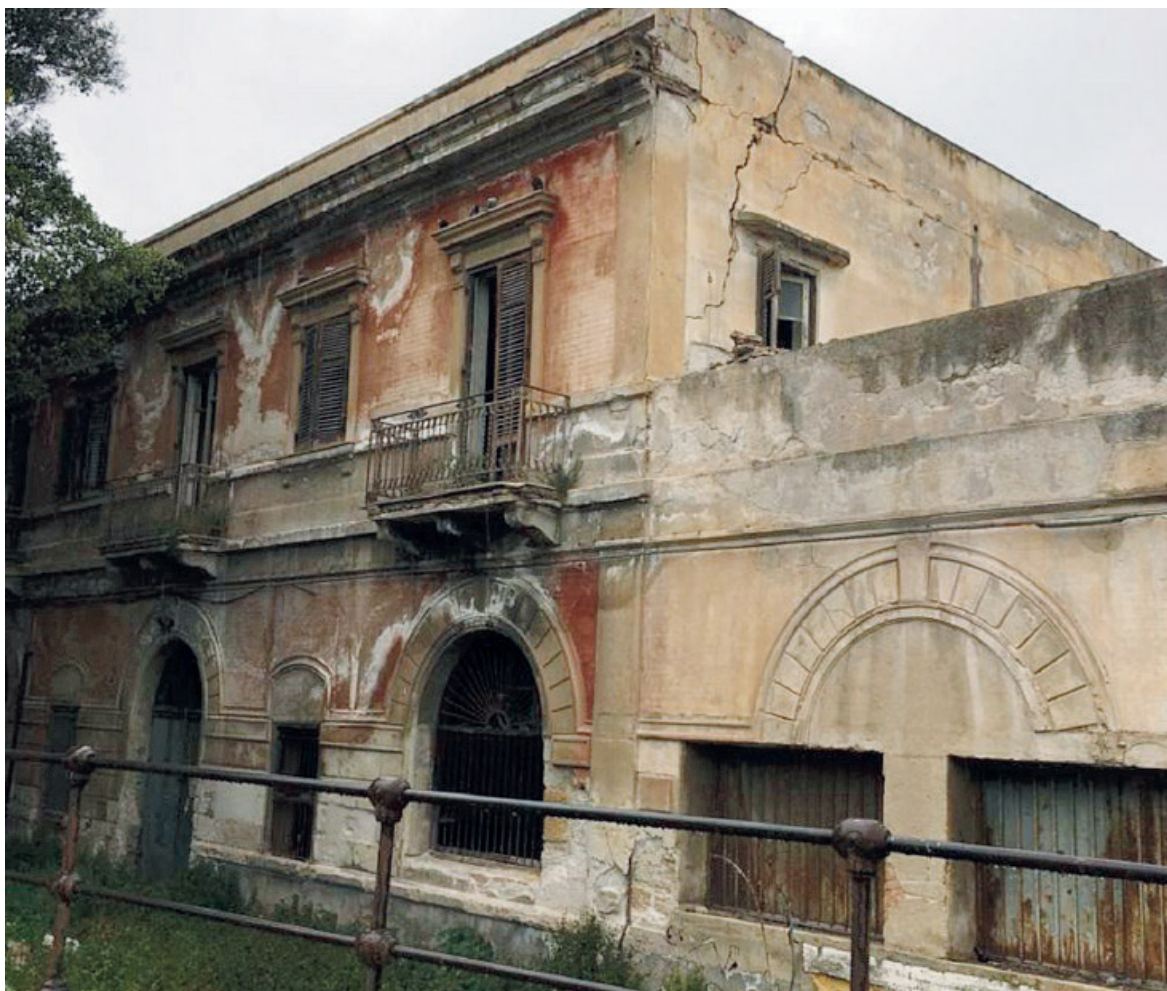
Palermo. L'edificio di via Messina Marine che diventerà una Casa di comunità
