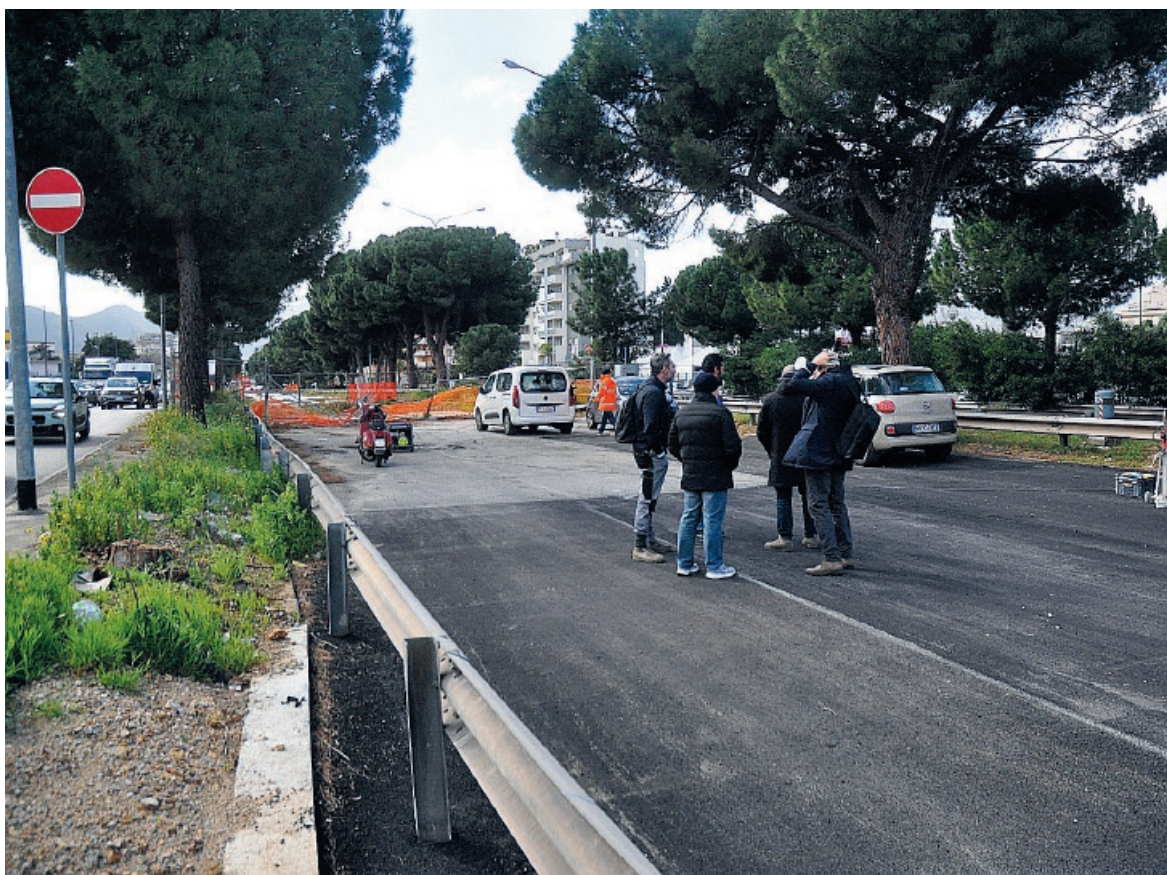
Viale Regione Siciliana. I tecnici nell'area del cantiere sul canale Mortillaro. FOTO FUCARINI
