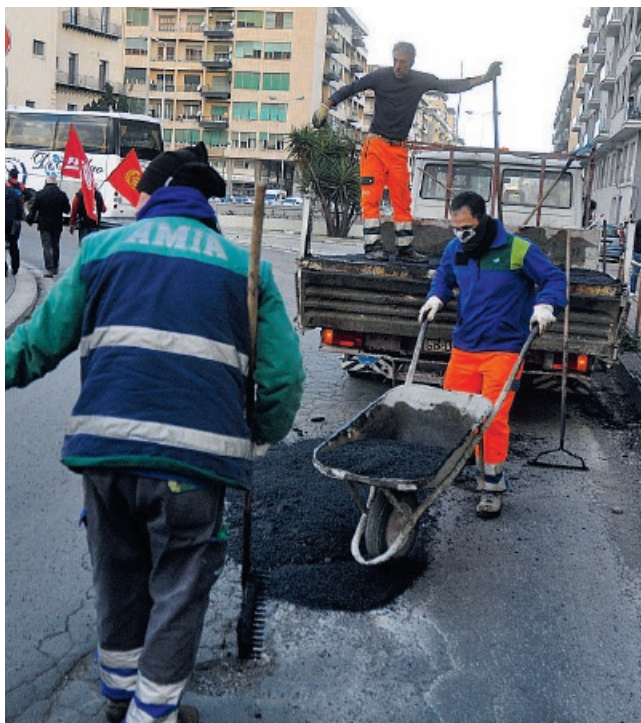
Rattoppi. Operai della Rap in via Crispi, una buca in piazza Indipendenza e le riparazioni in via del Vespro FOTO FUCARINI-2
