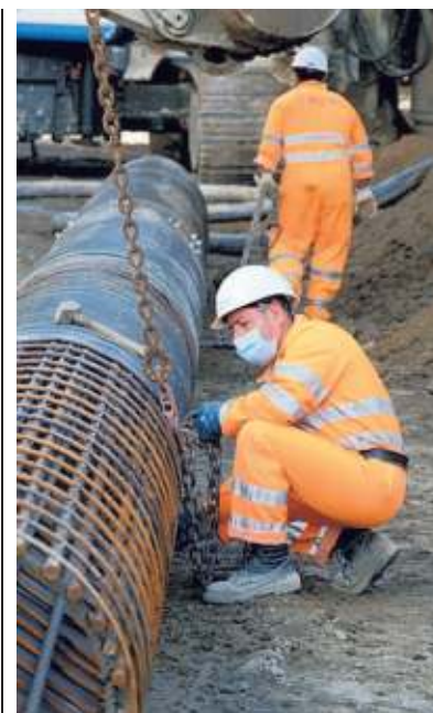
▲ Un cantiere Operai al lavoro
