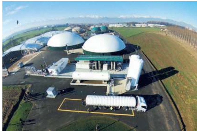
▲ La centrale Un impianto di trasformazione del compost in metano
