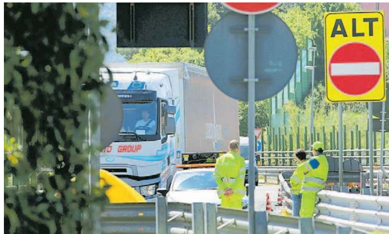
▲ Il cantiere Manutenzione sull'autostrada
