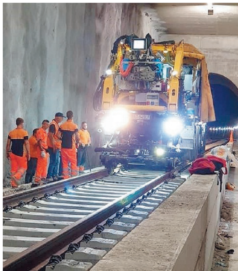
Anello ferroviario. Operai e tecnici nel cantiere di via Sicilia
