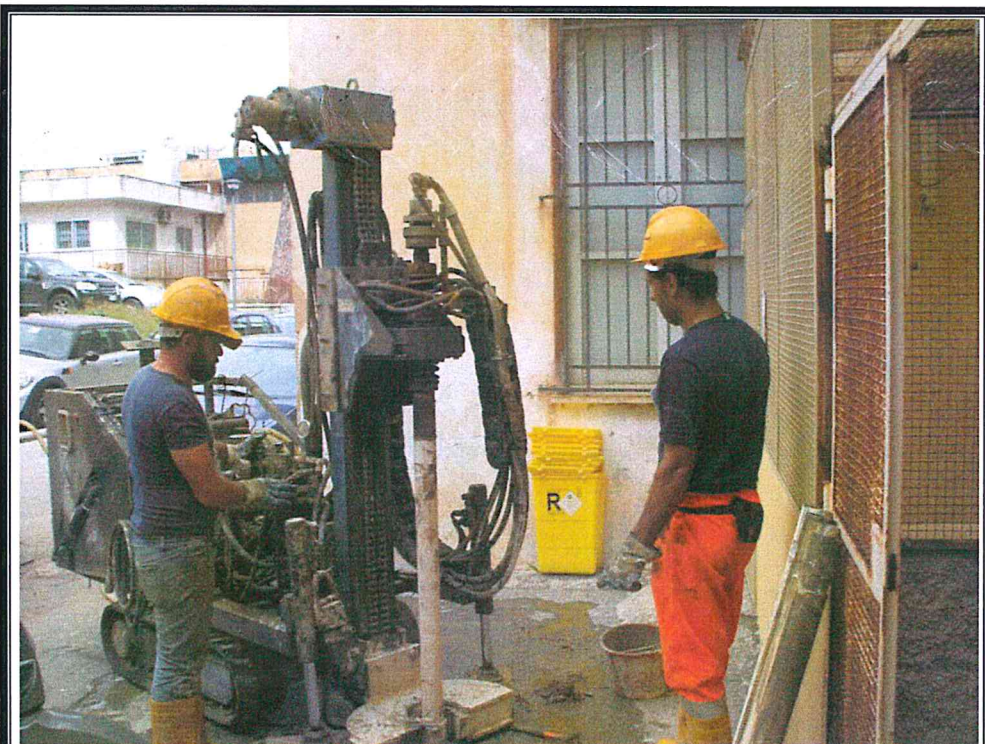
Postazione del sondaggio S6
