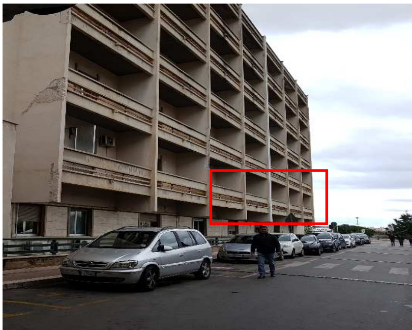
Foto 2: Fronte Sud dei blocchi "D" ed "E" con indicazione dell'area di intervento al piano 1°
