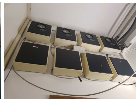
Spogliatoio medici - deposito
