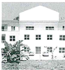
L'ingresso di Villa delle Ginestre
