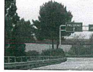
L'AUTOSTRADA A19 Riapre la Palermo-Catania | Si circola su una carreggiata
