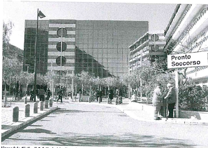
L'ospedale Giglio di Cefalù rischia di perdere Urologia e Oncologia e altri reparti
