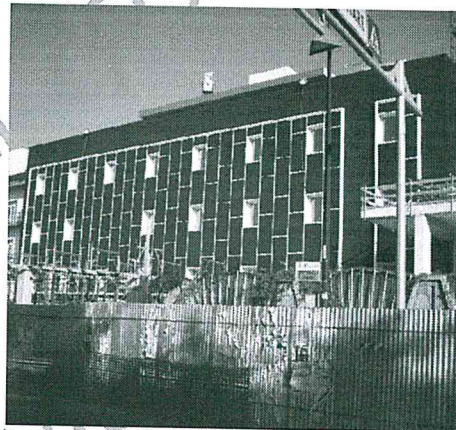
I lavori in corso all'ospedale «Abele Ajello» di Mazara del Vallo
