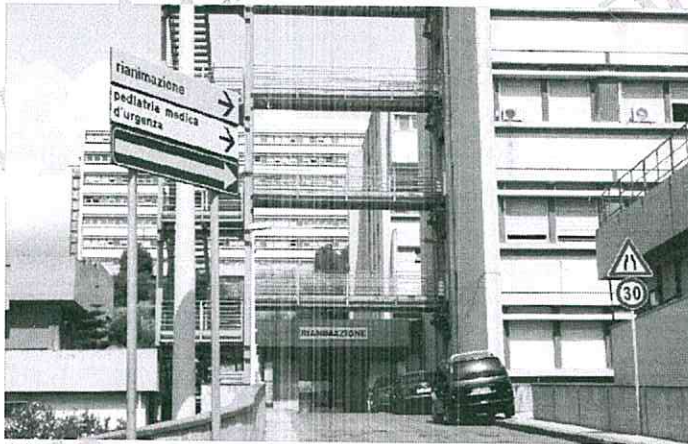
L'edificio della Rianimazione del Policlinico di Messina
