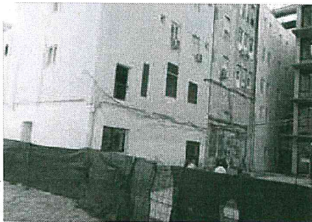
GLI ULTIMI LAVORI PER IL NUOVO PRONTO SOCCORSO DEL DI CRISTINA
