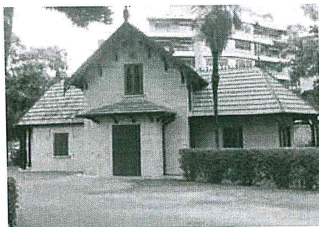
L'EX SARTORIA RISTRUTTURATA
