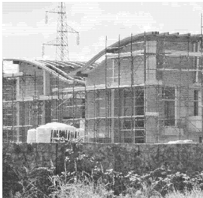
Un cantiere edile
